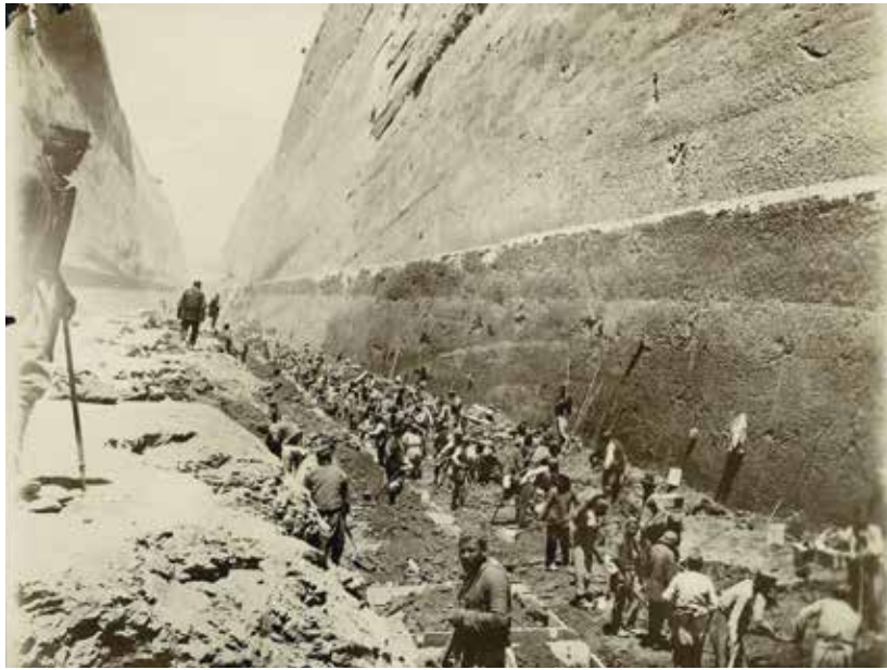
Από την κατασκευή της Διώρυγας της Κορίνθου. BNP Paribas, Historical Archives.
