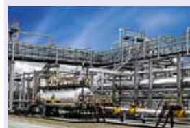
Εικόνα 1.7: Μονάδα δέσμευσης CO 2 από τα καυσαέρια εργοστασίου.
