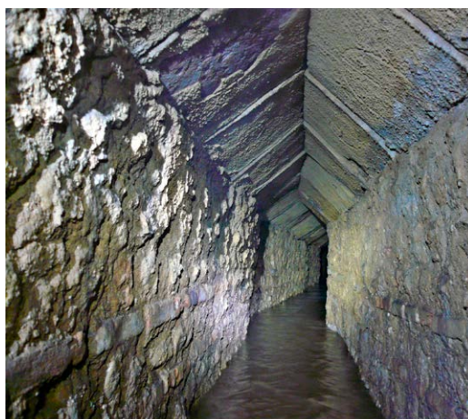
Εικόνα 2. Υπόγειο τμήμα μεταξύ φρεάτων 278-279 μήκους 70 m σε βάθος 15 m από την επιφάνεια (φωτ. Παναγιώτης Δευτεραίος/Αστική Σπηλαιολογία - ΥΠΠΟΑ/ΕΥΔΑΠ)
