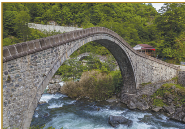
Τοξωτή γέφυρα στο Αρτβίν της Τουρκίας
