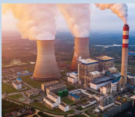
3.6.5: Θερμοηλεκτρικός σταθμός (Εργοστάσιο παραγωγής ηλεκτρικής ενέργειας).
