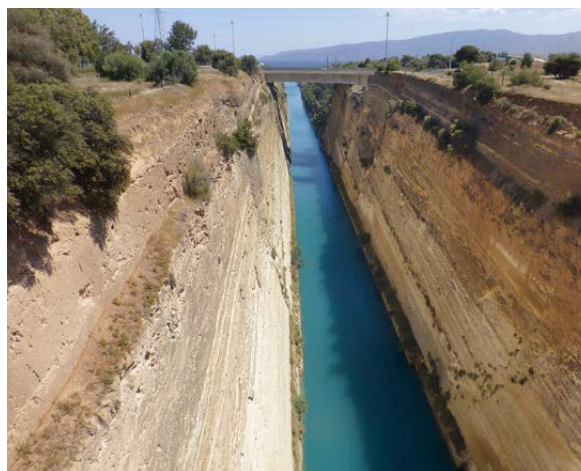
Εικόνα 5. Διώρυγα της Κορίνθου
