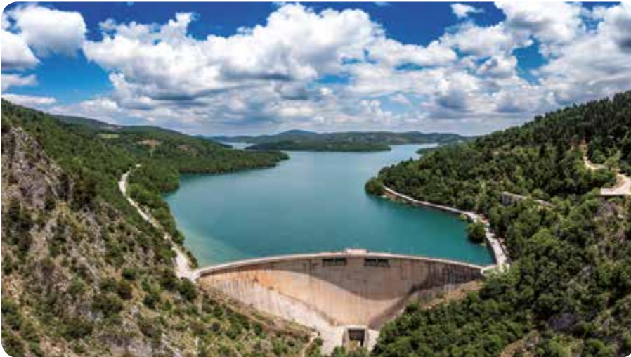
Φράγμα Λίμνης Πλαστήρα, Καρδίτσα
