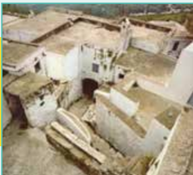
ΕΙΚΟΝΑ 3 Παραδοσιακός οικισμός της Τήνου. Χαρακτηριστικό είναι ότι εδώ δεν υπάρχει ανάγκη χρήσης επικλινούς στέγης κι έτσι δημιουργούνται επίπεδα δώματα για τη συλλογή του βρόχινου νερού (από το δώμα, το νερό οδηγείται στα λούκια και από εκεί στις στέρνες, όπου αποθηκεύεται). Το λευκό χρώμα το οποίο χρησιμοποιείται σε πολλούς νησιωτικούς οικισμούς (π.χ. των Κυκλάδων), συμβάλλει στη μείωση της ποσότητας της θερμότητας που απορροφάται από την εξωτερική επιφάνεια των τοίχων.
