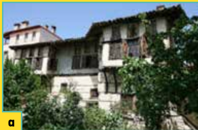
ΕΙΚΟΝΑ 2 α. Αρχοντικό Νεραντζόπουλου στη Σιάτιστα Κοζάνης. Διακρίνονται τα σαχνισιά, ξύλινες προεξοχές με μεγάλα και πολλά ανοίγματα, που χρησιμοποιούνται για να επιτευχθεί ο βέλτιστος αερισμός της μεγάλης σάλας και των καλών οντάδων, δηλαδή των καλοκαιρινών δωματίων υποδοχής στον επάνω όροφο, διακοσμημένων με ξυλόγλυπτα και τοιχογραφίες. β. Εσωτερική άποψη του νηπιακού, χειμερινού χώρου διημέρευσης στο μεσοπάτωμα. γ. Εσωτερική άποψη της μεγάλης σάλας.
