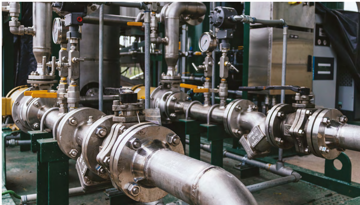
Εικόνα 5. Βαλβίδες ελέγχου ροής
