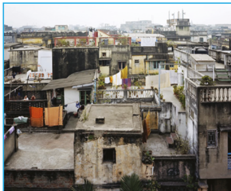
Εικόνα 3.4.3 Θέα από την οροφή του Dawn House, Βόρεια Καλκούτα, 2005
