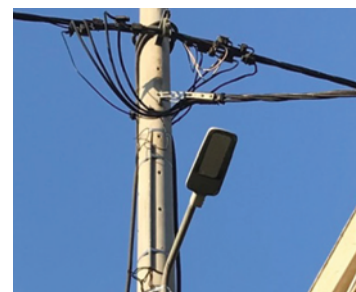
Εικόνα 2.3.16: Σήμερα πραγματοποιείται αντικατάσταση των γυμνών καλωδίων από συνεστραμμένα, μονωμένα καλώδια.
