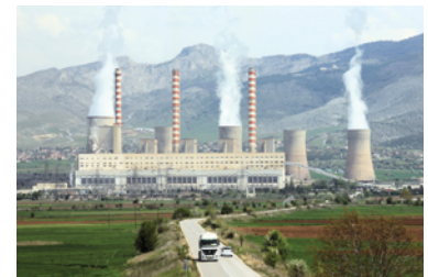
Εικόνα 1.8.22: Ατμοηλεκτρικός Σταθμός Αγίου Δημητρίου.
