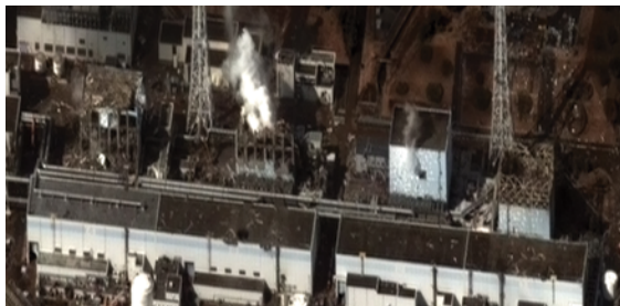
Εικόνα 4.1.23: Άποψη του εργοστασίου της Φουκουσίμα μετά την καταστροφή.
