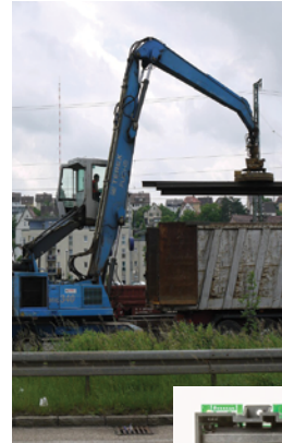
Εικόνα 2.2.2: Ηλεκτρομαγνητικός γερανός μεταφέρει σιδηροτροχιές.
