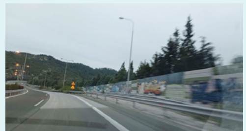
Εικόνα 6.3.13: Ηχοπετάσματα παραπλεύρως του δρόμου και σειρά δέντρων
