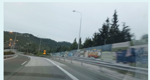
Εικόνα 6.3.13: Ηχοπετάσματα παραπλεύρως του δρόμου και σειρά δέντρων
