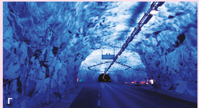
Εικόνα 3.5.9 Μεγάλα τεχνικά έργα στην Ευρώπη και στην Ελλάδα: Α) Σήραγγα της Μάγχης. Β) Σήραγγα βάσης Γκότάρντ (ή Γκοτάρντ). Γ) Σήραγγα Λάρντλαλ.
