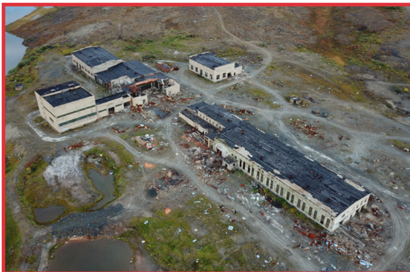
Σήμερα, το κτίριο είναι εντελώς κατεστραμμένο και εγκαταλελειμμένο, με το σημείο της γεώτρησης να είναι απλώς ένα σφραγισμένο μεταλλικό καπάκι ανάμεσα σε ερείπια.
