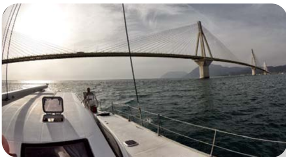
Γέφυρα στον πορθμό του Ρίου-Αντιρρίου
