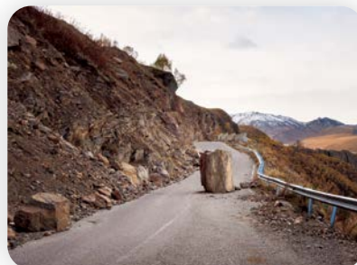
B.6.3 Πτώση βράχου από γρανίτη στο οδικό δίκτυο, έπειτα από σεισμό
