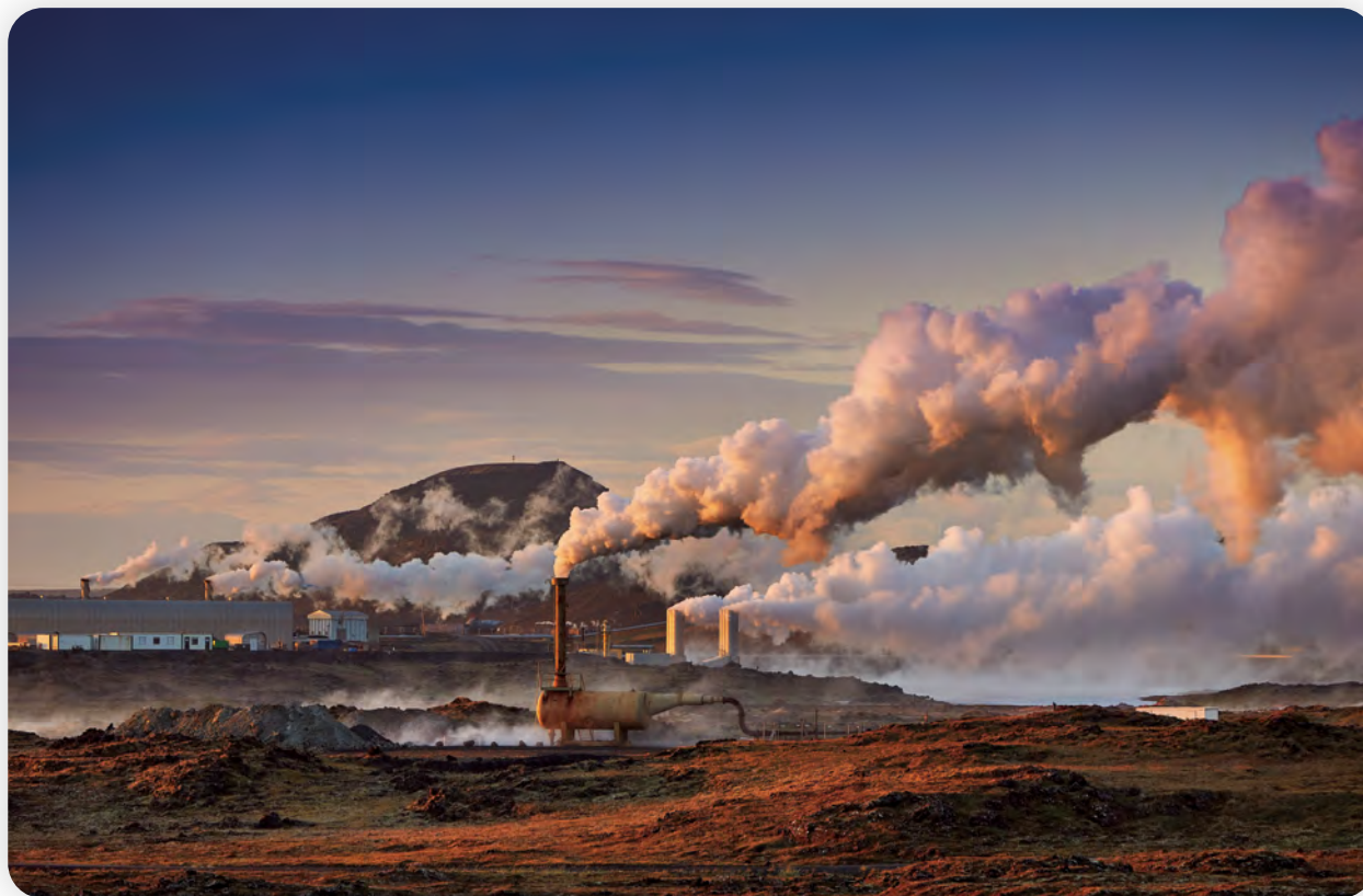
Γ.6.3 Σταθμός αξιοποίησης γεωθερμικής ενέργειας στην Ισλανδία
