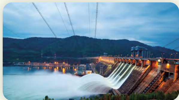
Γ.5.10 Το φράγμα των Κρεμαστών στο μεγαλύτερο υδροηλεκτρικό έργο της Ελλάδας, με συνολική ισχύ 440 MW
