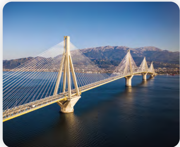
Γ.5.3 Η καλωδιωτή γέφυρα Ρίου - Αντιρρίου
