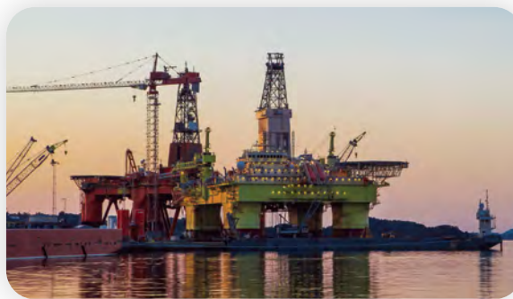
Γ.7.4 Πλατφόρμα άντλησης πετρελαίου στο Μπέργκεν της Νορβηγίας (δευτερογενής τομέας)
