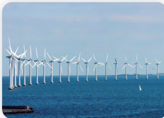
Γ.6.2 Υπεράκτιο αιολικό πάρκο στη Βαλτική Θάλασσα
