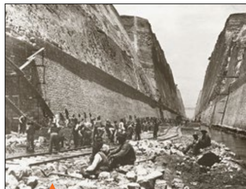
Φωτογραφία από το εργοτάξιο στον Ισθμό της Κορίνθου (Ιστορικό Αρχείο Μουσείου Μπενάκη, Αθήνα). Η κατασκευή της διώρυγας της Κορίνθου (περίπου 1890), ένα από τα σημαντικότερα έργα της κυβέρνησης Τρικούπη.
