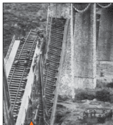
Η ανατίναξη της γέφυρας του Γοργοπόταμου
