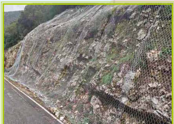
Εικόνα 12.3. Κάλυψη των πρανών με μεταλλικό πλέγμα
