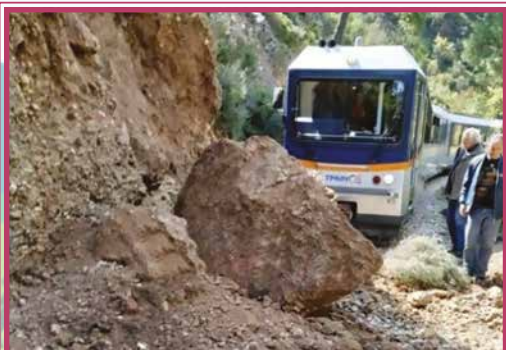
Εικόνα 12.2. Εκτός λειτουργίας ο οδοντωτός λόγω κατολίσησης
