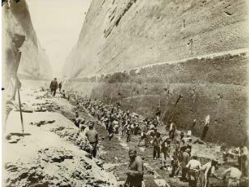
Από την κατασκευή της Διώρυγας της Κορίνθου .
