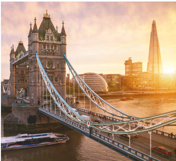
Εικόνα 10.10. Η Γέφυρα του Πύργου, Λονδίνο, Ηνωμένο Βασίλειο.
